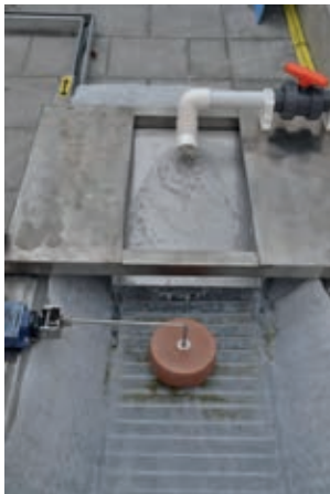
Figuur 3 Vlakbedfilter (Fiber Filtration) zoals gebruikt in de emissieloze kas.
