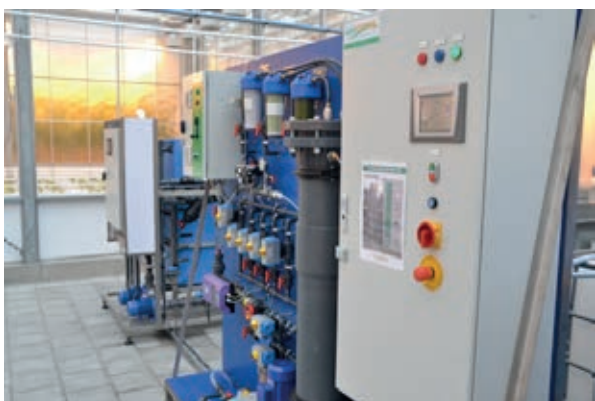
Figuur 4 Ozon ontsmettings- en zuiverings-apparatuur met microfilter (Agrozone).
