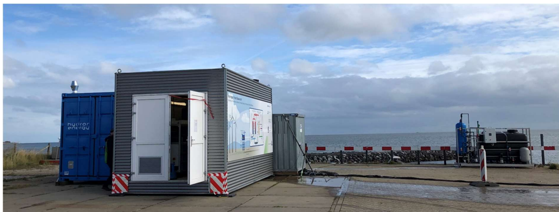
Figuur 8: PEMWE (blauwe container) en MD (grijze container) installatie met rechts op de kop van de kade de geïnstalleerde zee water intake.
