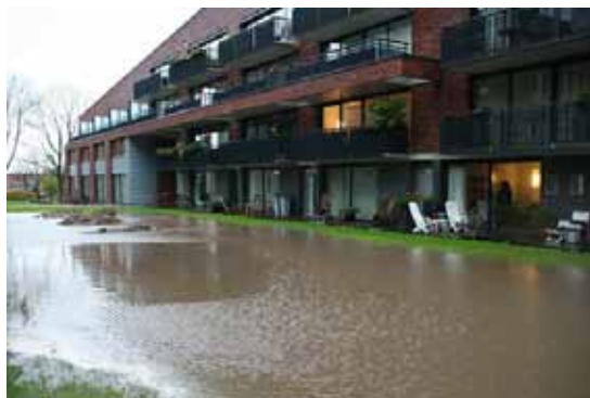
schadebeeld: Nijmegen, wateroverlast door verdichting bodem bij aanleg van Limosterrein
