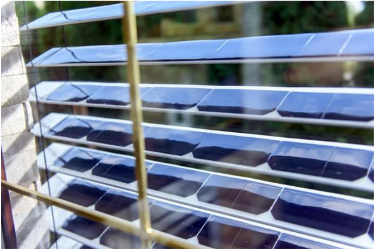
Figuur 26 Zonopwekking via zonwering (bron: https://www.duurzaamgebouwd.nl/artikel/20080811-pv-wirefree-zonwering ).
