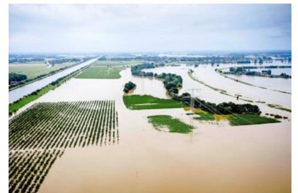
Overstroming (Limburg) (foto: www.nationaalrampenfonds.nl )
