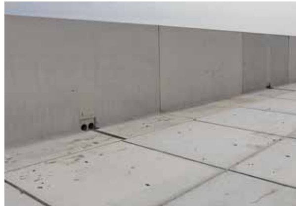
Figuur 6 Duo-afvoergoot voor gescheiden lozing van hemelwater en perssappen.
