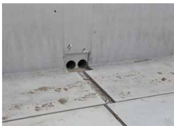
Figuur 5 De gescheiden afvoer van de nieuwe sleufsilos van de broers Koopman.
