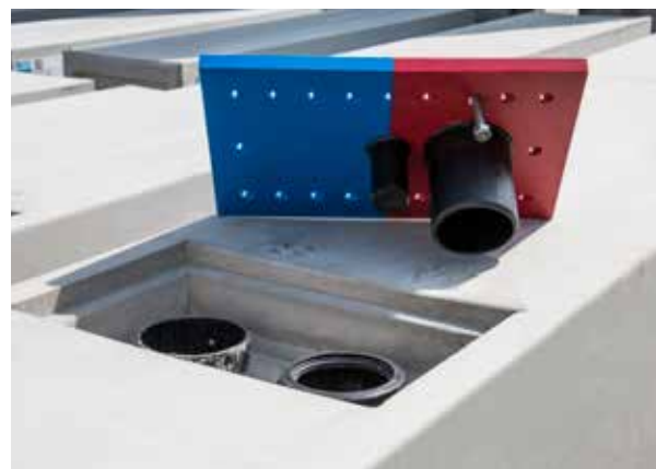
Figuur 4 Door de putdeksel om te draaien verandert de waterafvoer van perssap naar percolaatwater.
