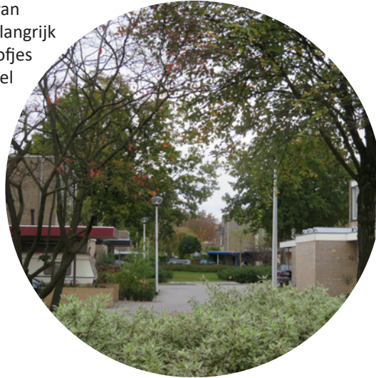
Woonerf in Veldhuizen B in Ede, gebouwd in de jaren '80
