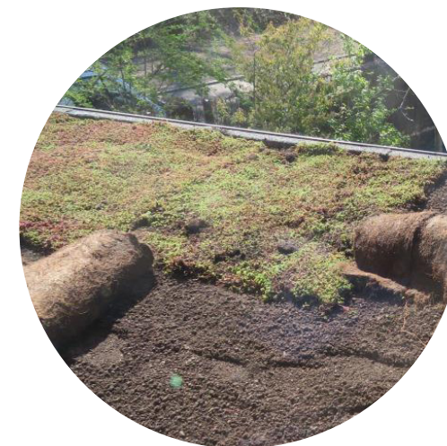
Substraat en sedumrollen voor groendak
