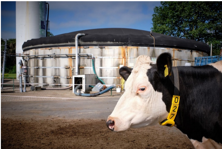
Bovengrondse mestsilos met afdekking.
