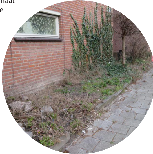
Geveltuinen kunnen verwaarloosd raken
