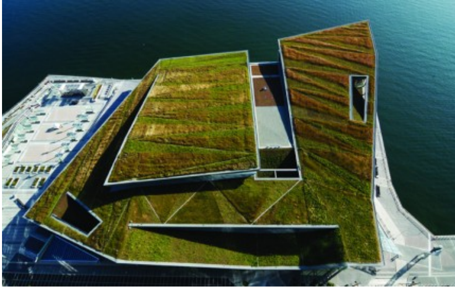
Figuur 15 Groendak op het Vancouver Convention Centre
