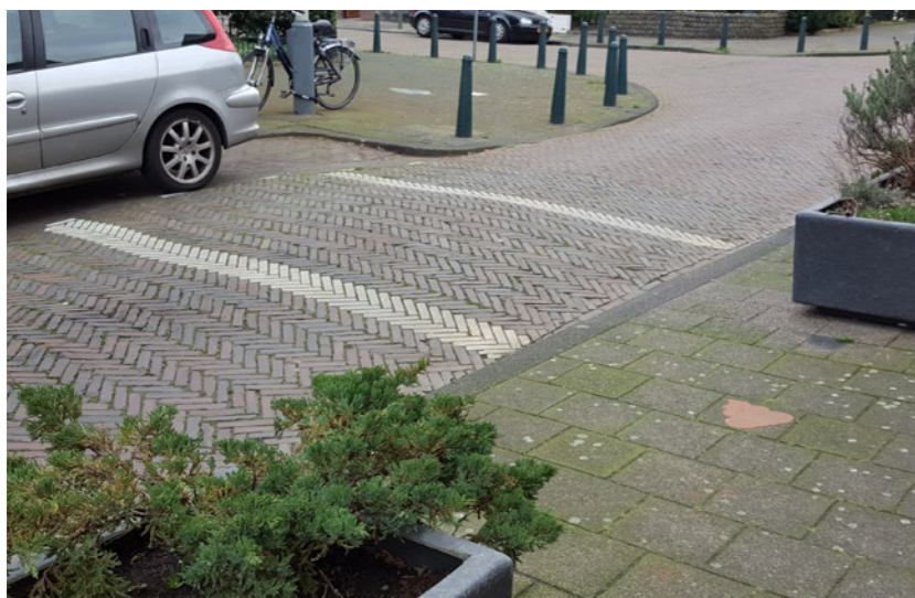
Oversteekplek in Den Haag op zichzelf staand verkeerselement deels geblokkeerd door geparkeerde auto
