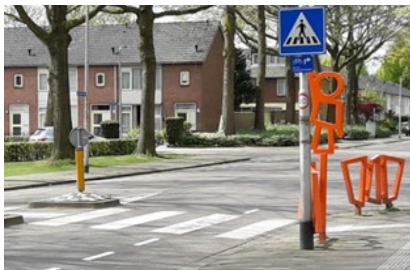
Oversteekplek met verticale elementen in Tilburg
