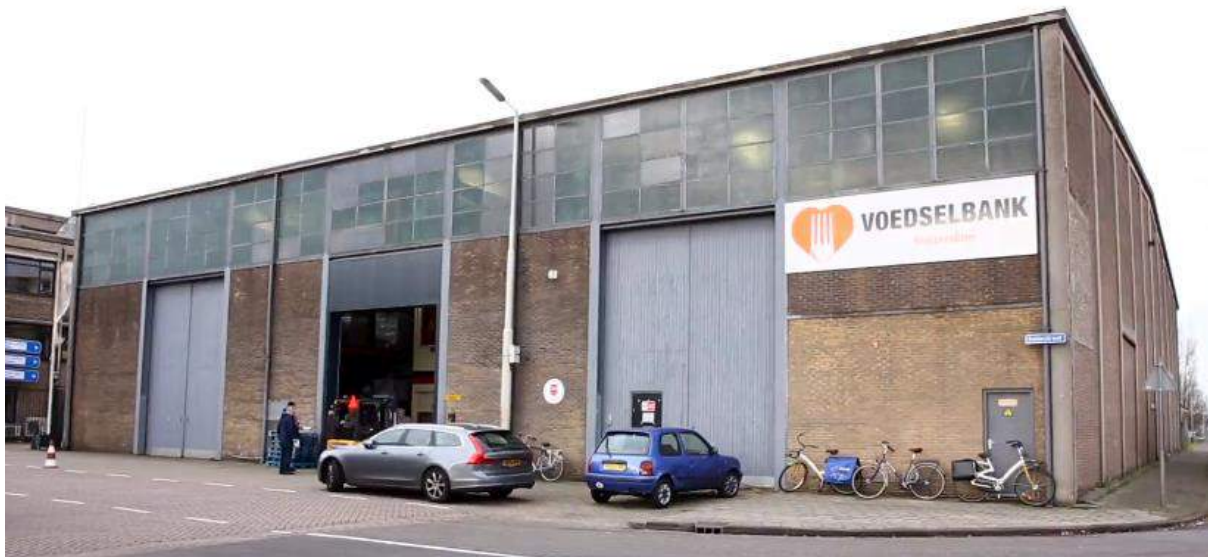
Image 2: The distribution centre of the Voedselbank Rotterdam (Metro, 2018)
