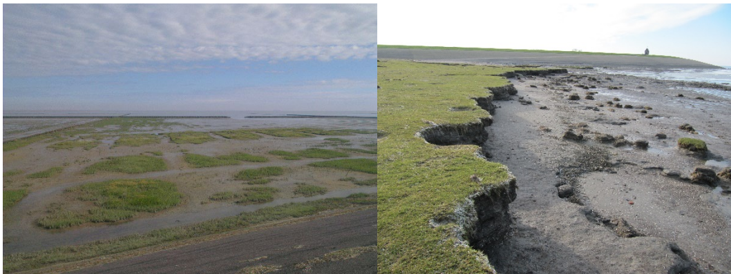
Figuur 1.4 Erosie aan de oostzijde van de kwelderwerken in de provincie Groningen (links) en de eroderende rand van de kwelder bij Wierum (rechts).
