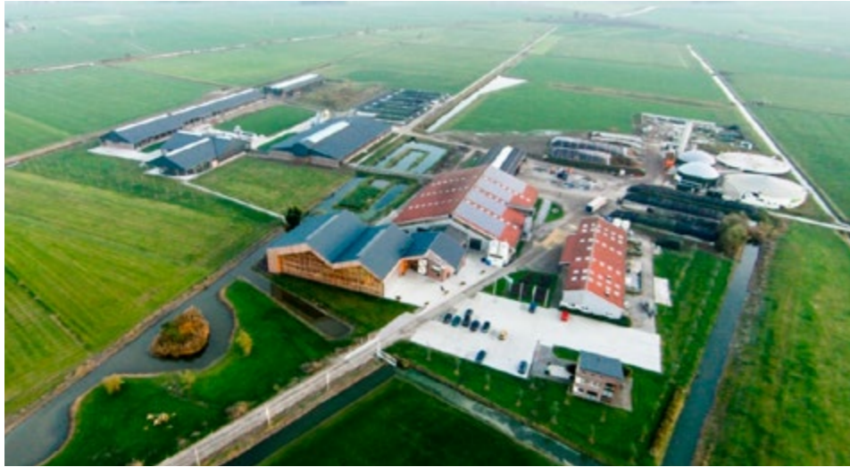
Figuur 7 Dairy Campus in Leeuwarden – regenwater opvangen, bergen en opwaarderen
